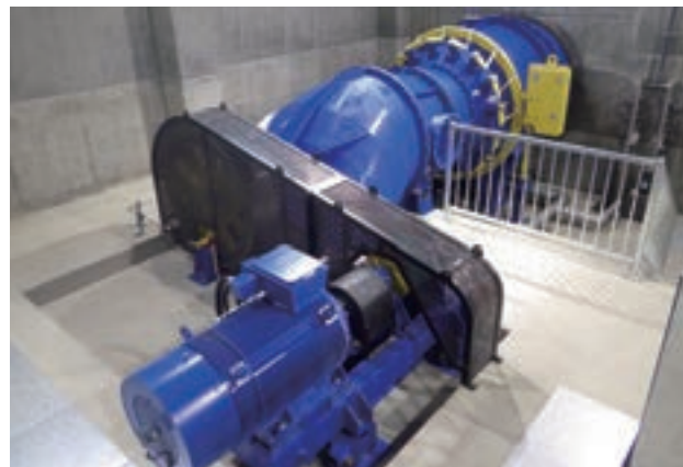
S型チューブラ水車・発電機
