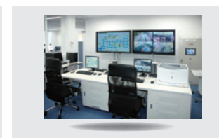
综合监控系统
